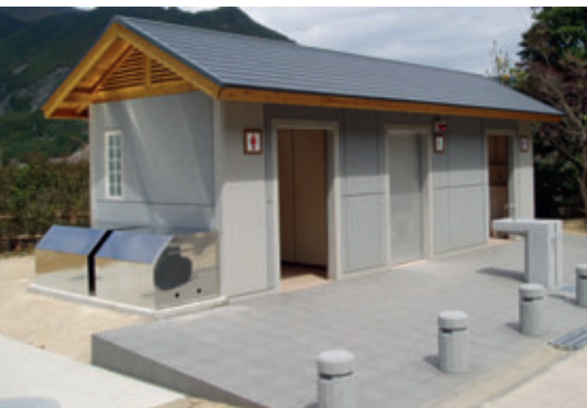
Figure 1 : les toilettes publiques deviennent ainsi un espace polyvalent (avec coin maquillage, espace à langer, etc.) qui doit être aisément accessible aux personnes à mobilité réduite et aux personnes âgées.
