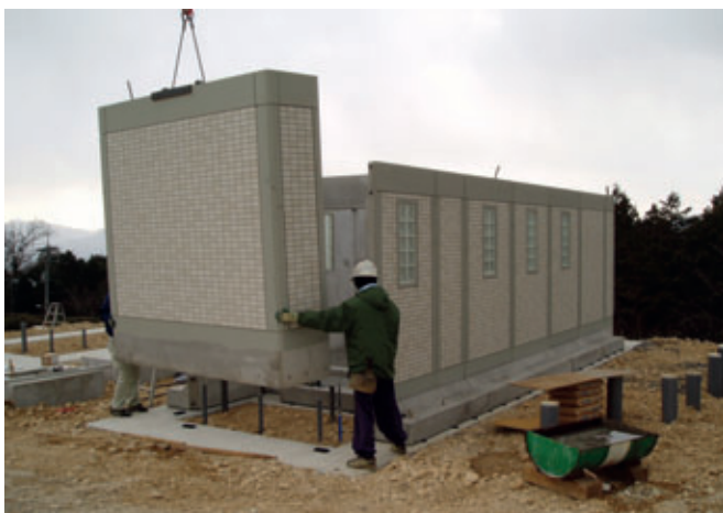
Fig. 2 et 3 : assemblage des éléments préfabriqués sur chantier
